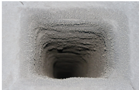
Ten sam komin po mechanicznym usunięciu smoły i nauce poprawnego palenia. Sadzy jest mało i jest sypka, przy regularnym czyszczeniu ryzyko pożaru bliskie zera.
