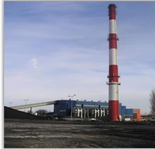
KOTŁOWNIA REJONOWA nr 1
