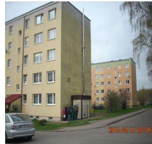
KOTŁOWNIA REJONOWA nr 3
