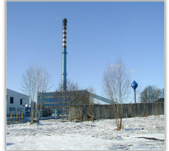
KOTŁOWNIA REJONOWA nr 2
