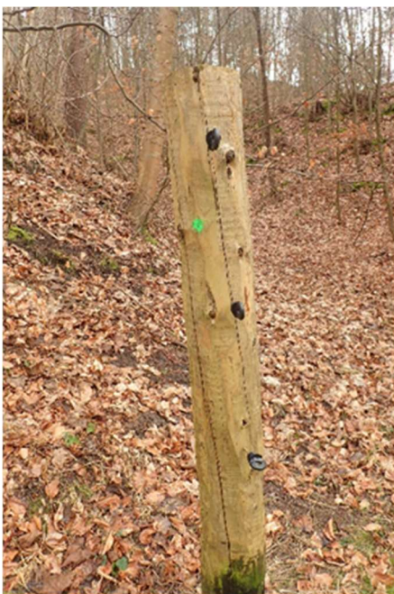
Fot. nr 1 Słup do przeniesienia oznaczony zielonym kolorem
