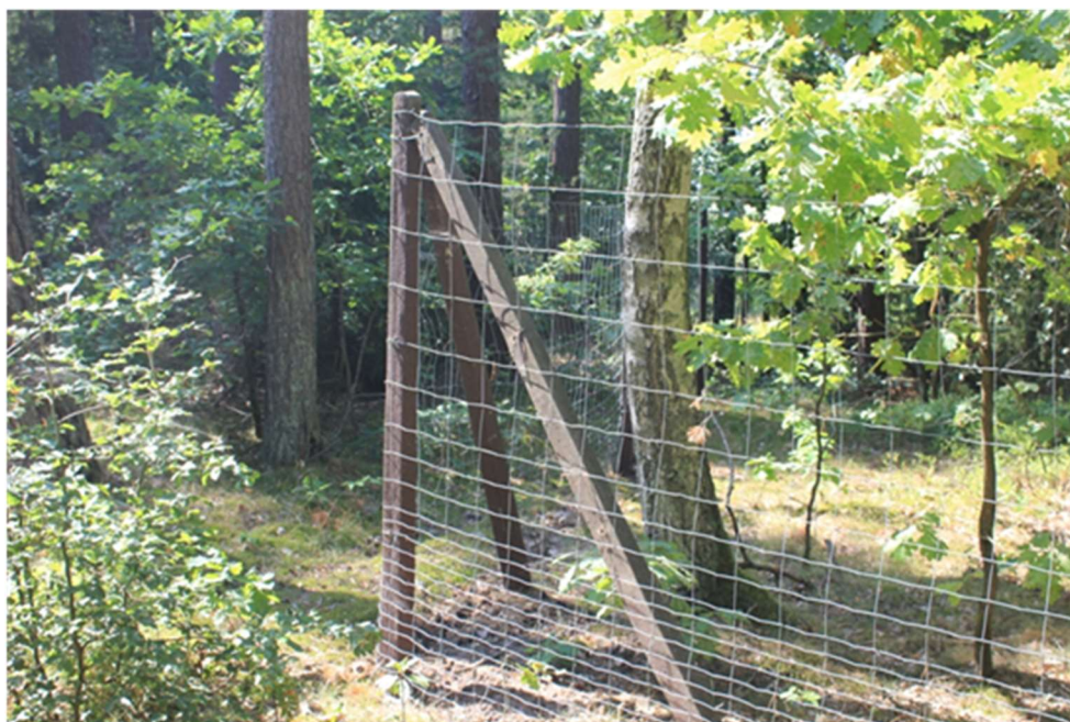
Fot. nr 2 Przykładowe wzmocnienie grodzienia na załamaniu wykonane ze słupków betonowych w rezerwacie przyrody „Cisy nad Czerską Strugą”.
